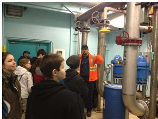
*Olivier Brunet, opérateur en assainissement des eaux, explique comment les pompes acheminent l'eau de la station de traitement vers le réseau d'aqueduc de la ville de Mont-Tremblant.*
